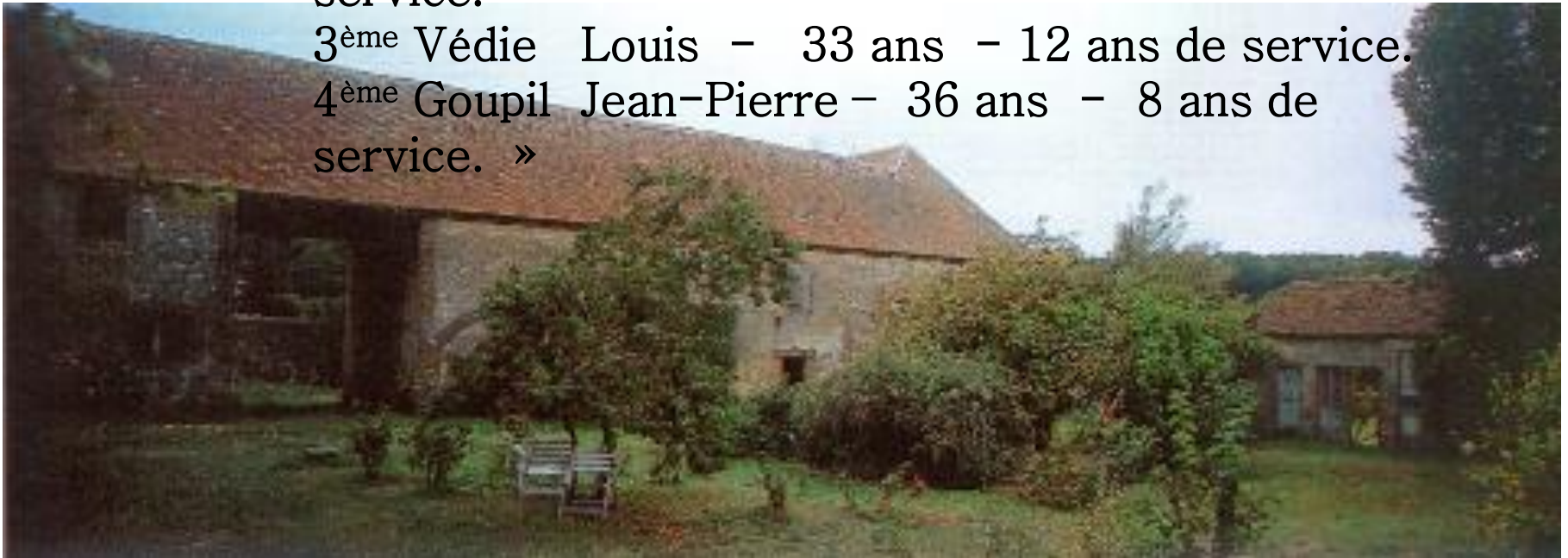
Arrière cour et remise du relais
